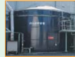
消化液貯留槽
